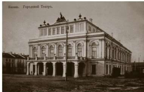
Здание Казанского городского театра
